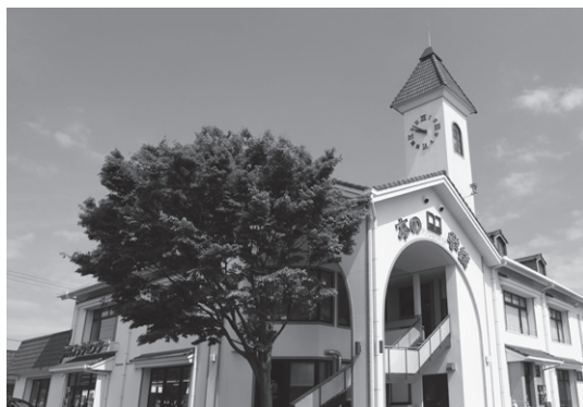
1995年に本の学校実習店舗として建築、現在は「本の学校今井ブックセンター」 写真提供=前田昇
